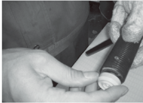
⑤ Overflødig smørefett blir presset ut av ventilasjonshullet
